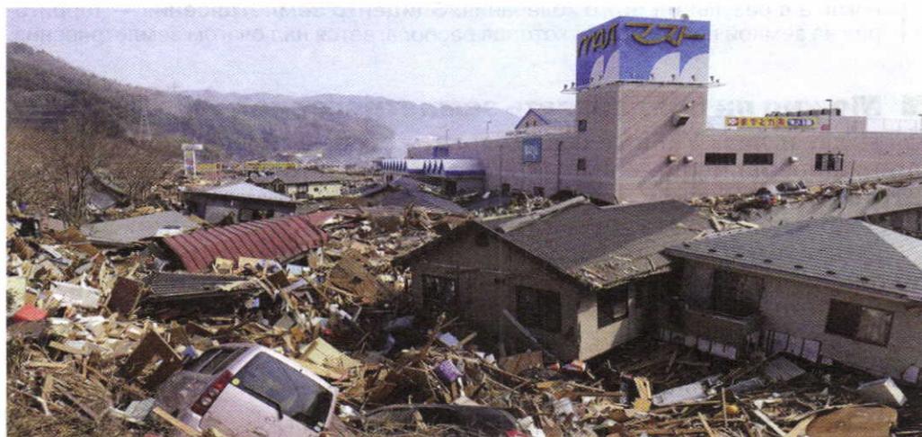
Рис. 118. Последствия сильного землетрясения
